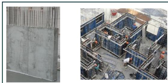
Muro de concreto vaciado en obra. También conocido como muro en sistema industrializado.
