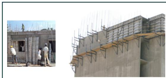
Muro de concreto vaciado en obra. También conocido como muro en sistema industrializado o muro pantalla.
